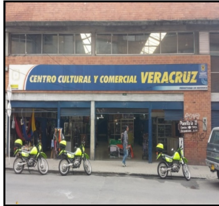
Foto No. 2. Fachada del predio de la Calle 17 No.4-65
